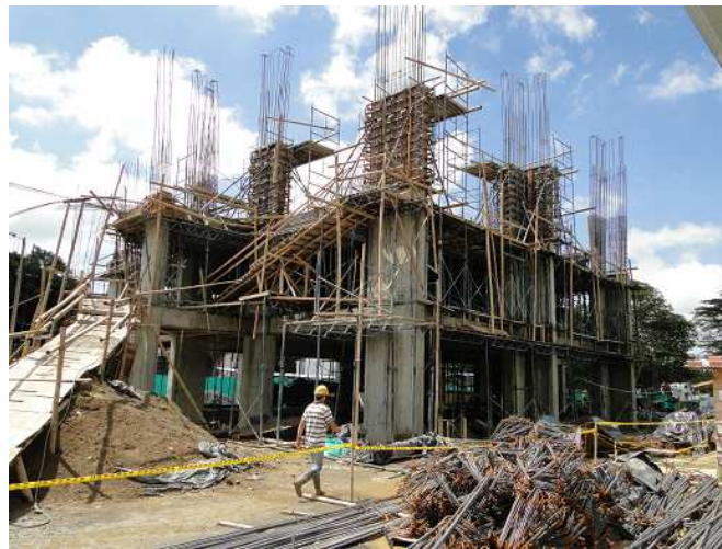
BLOQUE DE AULAS PLACA TERCER PISO Y FORMAleta COLUMNAS
