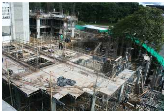
AULAS MAGISTRALES FORMALETA PLACA Y VIGAS AÉREAS
