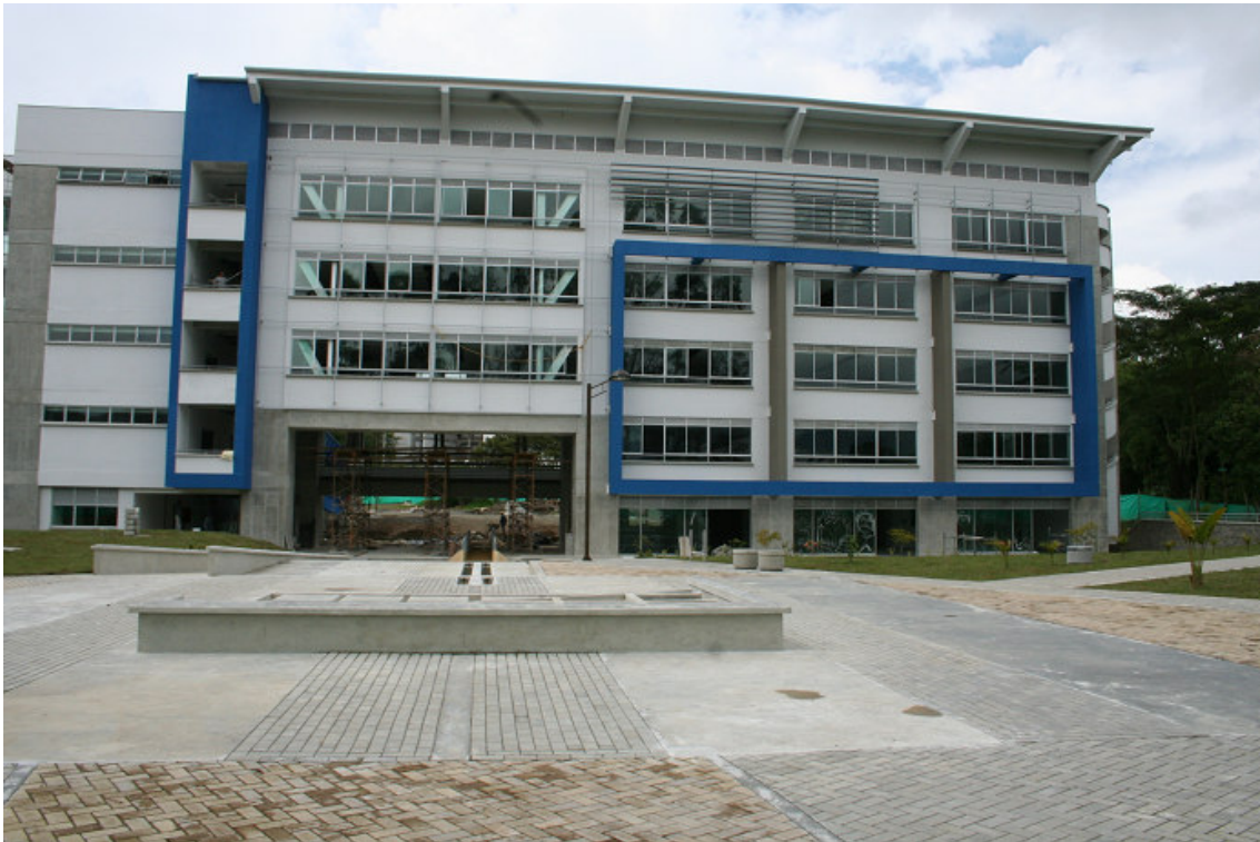
Vista norte Módulo norte y bloque de sistemas
